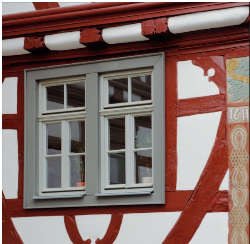
PaXpur in einem Kulturdenkmal von 1611. Durch die feinen Profile wirken selbst Fensteröffnungen mit ca. 70 x 120 cm wohl proportioniert.
